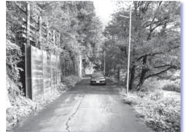
▲町道湯尾社谷線道路改良
