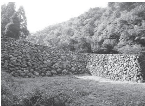
アカタン砂防(松ヶ端えん堤)
