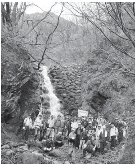
高倉谷川砂防ハイク(立成4号えん堤)
