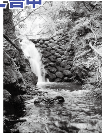
高倉砂防 西高倉堰堤
