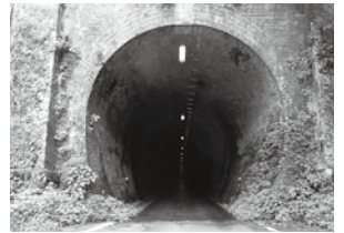
山中トンネル
