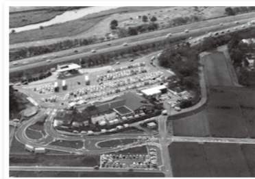
▲サービスエリアを活かした周辺整備
