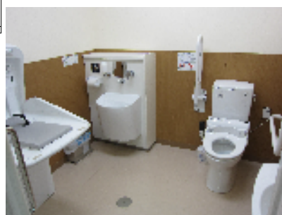
多目的トイレの設置
