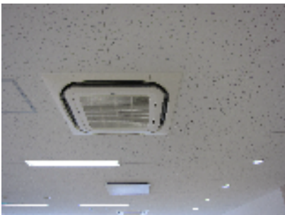
空調設備の改修
