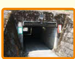
4 ガード下トンネル (暗い)
