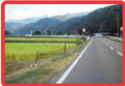
6 スポーツパーク476 北側道路(ガードレ ールなく危険)
