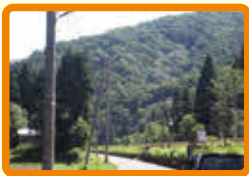
1 今庄杉津線全線 (防犯灯少なく暗い)
