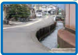
5 用水路が続いていて、水量の多い時期には特に注意が必要である。
