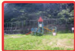
16 栄区の公園 (山肌が崩れる恐れ)
