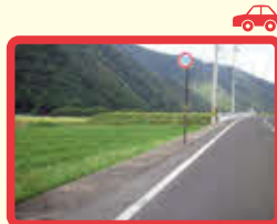
4 長沢 476号線 (ガードレールなく 危険)
