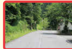
7 上温谷集落内道路 (ガードレールがなく、 路肩が狭い。カーブ で見通しが悪い。)
