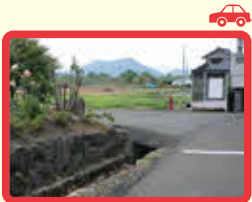
6 道路横に用水路があり、自転車は注意が必要である。
