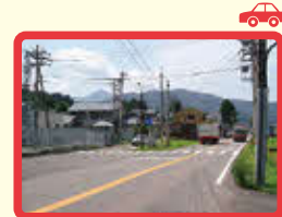
13 国道365号線との 交差点で、信号機 がない。
