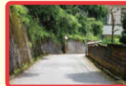
8 杉谷集落内道路 (道 路が狭く、見通しが 悪い。)
