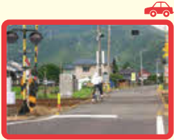
4 踏切の道路が狭いため、特に車が来たら危ない。
