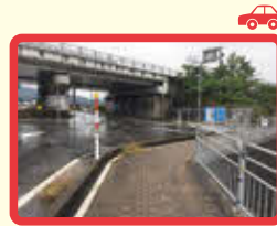
11 スリップした車が歩道に突っ込んでくるおそれがあり危険
