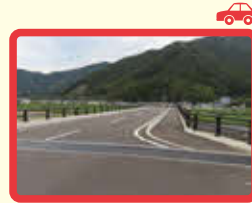
12 上平吹橋完成により、交通量が多くなり、スピードを上げて、車が走る。
