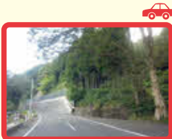
1 八乙女～社谷間山道 (道路外側ライン なく危険)
