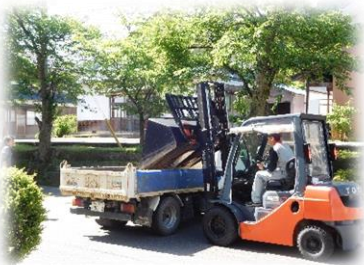
側溝の泥あげです
