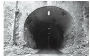
山中トンネル
