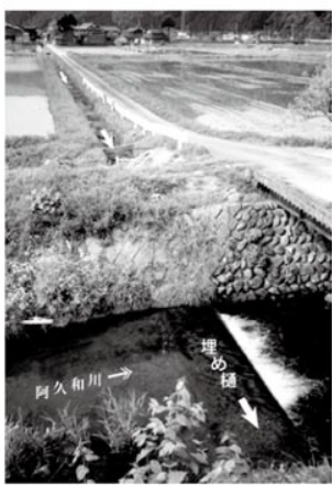
▲途中の川には埋め橋を設け水を流していた
