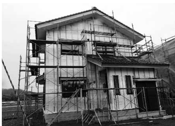
新築の木造住宅（南条保育所跡地）
