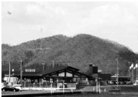
南条 SA 上線付近の地域振興施設建設予定地
