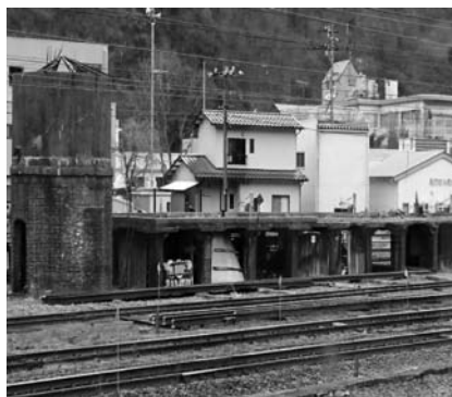
今庄駅舎 給水塔・給炭台跡
