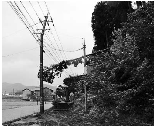
台風21号による被害状況
