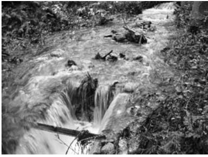
平成29年10月台風21号被害
