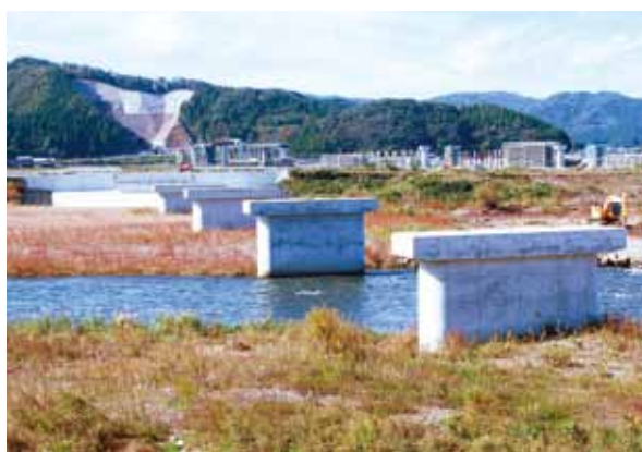
上平吹橋架け替え工事現場
