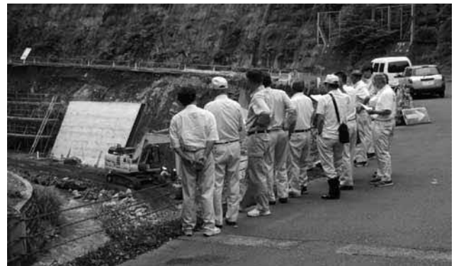
赤萩区町道復旧工事の様子
