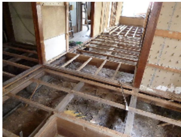
傷んだ床や壁を剥がして改修準備。この作業に一般ボランティアが参加しています。
